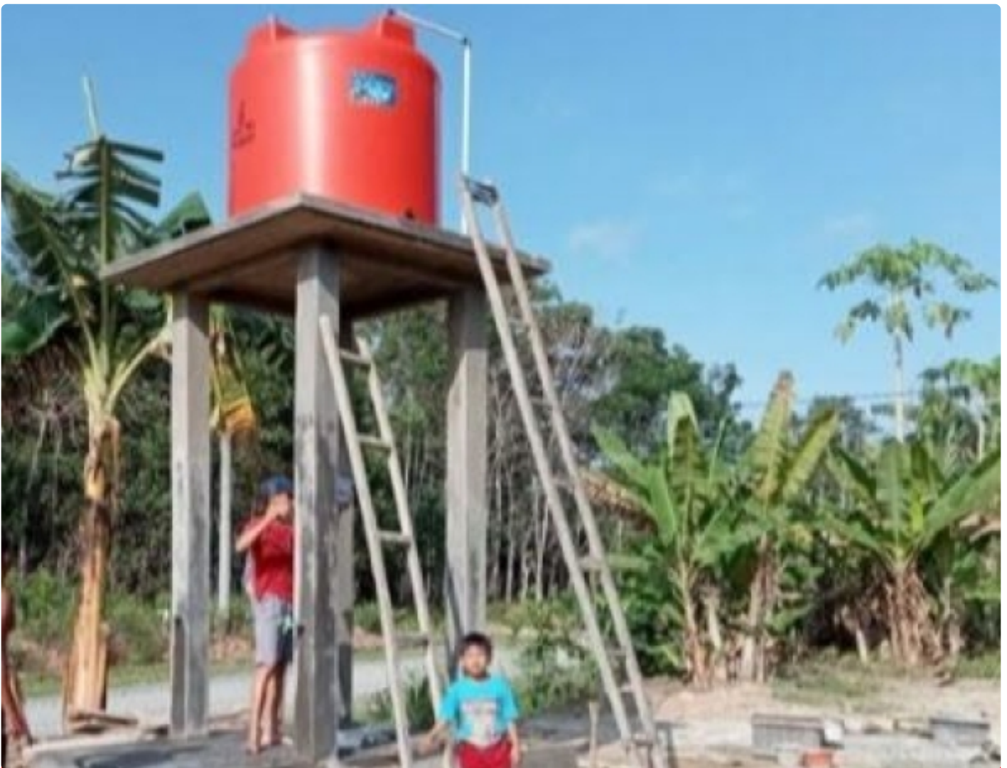
Pembangunan sumur bor di Desa Fajar Baru
