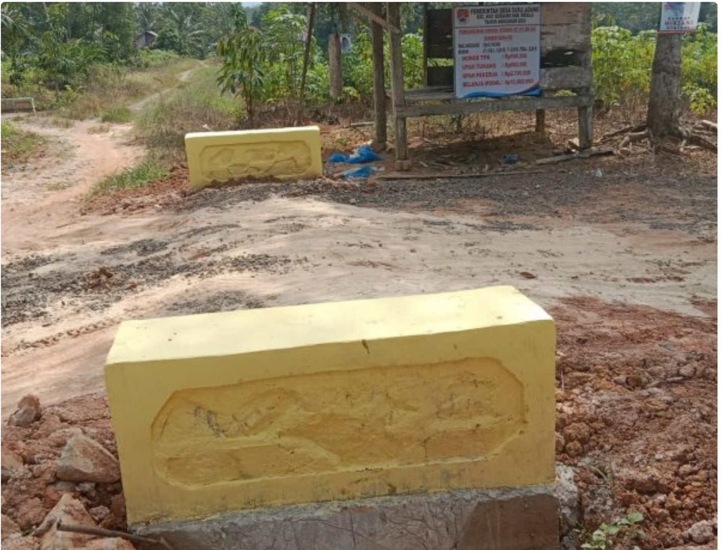
Pembangunan gorong-gorong Desa Suka Agung
